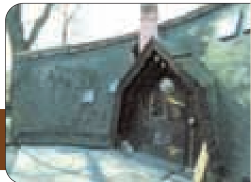
Bananhuset på Christiania er bygget af Naverne.
